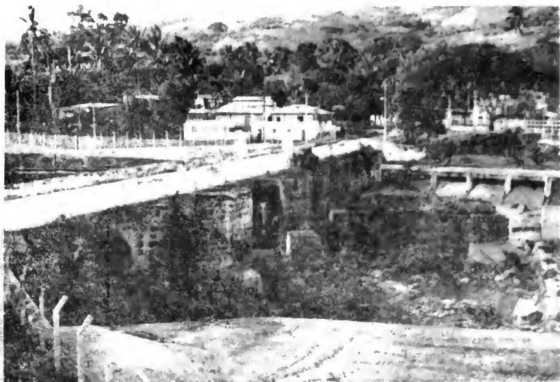
Vista del famoso puente de Los Esclavos. A la derecha se aprecia la punta de diamante de piedra construido para proteger el puente, mediante la detención de árboles y obstáculos que arrastra el río. (Foto de F.P.S.)
